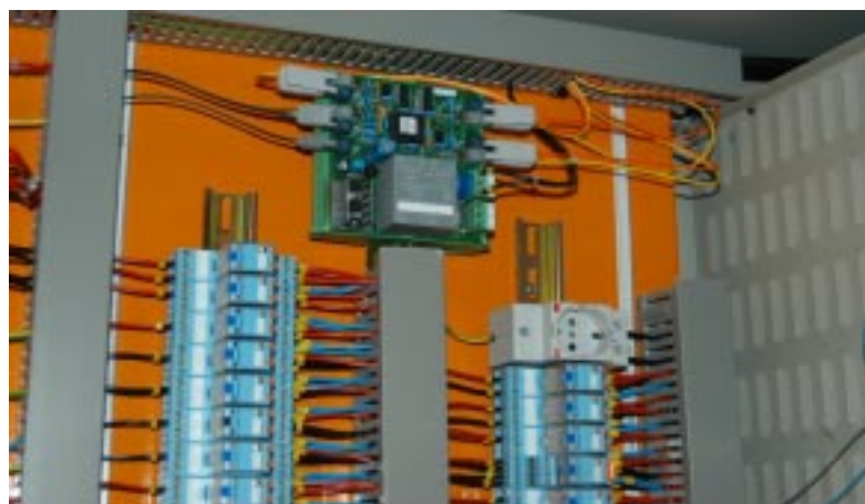
Figura 13 acceso a los generadores para la conectorización y sangrado
